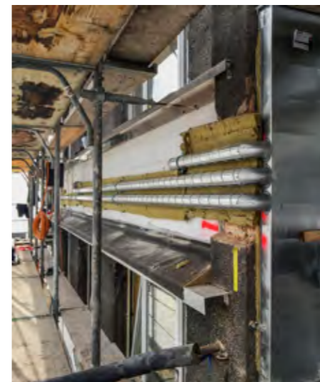
Drei Fliegen auf einen Schlag: Bei der energetischen Sanierung der Strassenfassade wird zuerst die neue Lüftung eingebaut, dann die verbesserte Wärmedämmung montiert und zum Schluss das Ganze mit den individuell gestalteten Photovoltaik-Modulen verkleidet.
