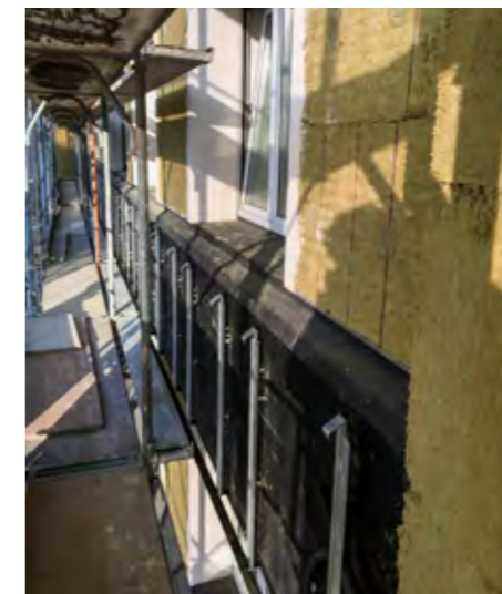
Drei Fliegen auf einen Schlag: Bei der energetischen Sanierung der Strassenfassade wird zuerst die neue Lüftung eingebaut, dann die verbesserte Wärmedämmung montiert und zum Schluss das Ganze mit den individuell gestalteten Photovoltaik-Modulen verkleidet.
