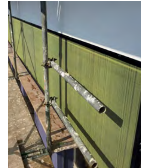
Drei Fliegen auf einen Schlag: Bei der energetischen Sanierung der Strassenfassade wird zuerst die neue Lüftung eingebaut, dann die verbesserte Wärmedämmung montiert und zum Schluss das Ganze mit den individuell gestalteten Photovoltaik-Modulen verkleidet.
