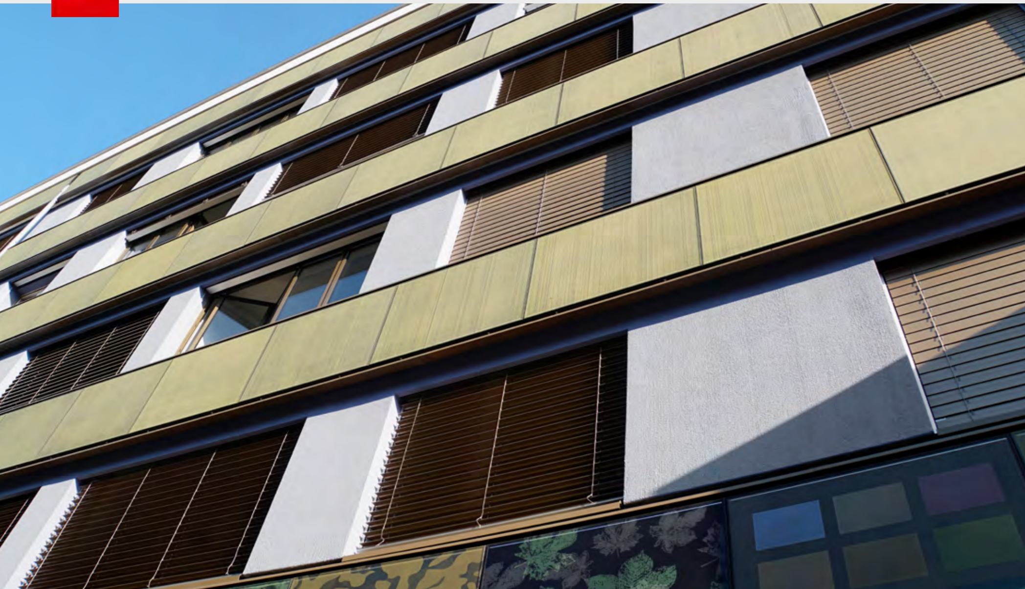
Links: Die gelb-grün satinierten Photovoltaik-Module an der Dornacherstrasse 109 in Basel sind Teil der attraktiven Fassadengestaltung.
